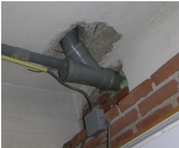
Figuur 1 PVC-doorvoering door vloer tussen winkel en woning
