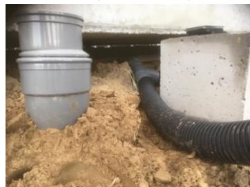
Afbeeldingen 1, 2 en 3 Foto's: verkeerde aansluiting hemelwaterafvoer
