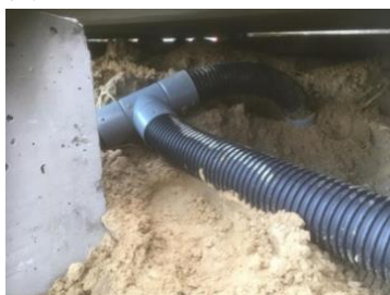
Afbeeldingen 1, 2 en 3 Foto's: verkeerde aansluiting hemelwaterafvoer
