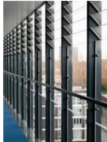
Figuur 4 voorbeeld open gevel met lamellensysteem
